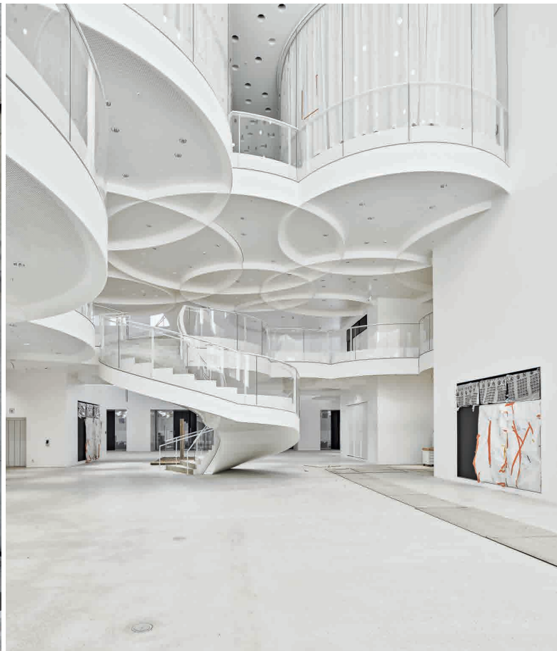
Halle mit Stucco-lustro-Arbeiten im Fertigzustand
