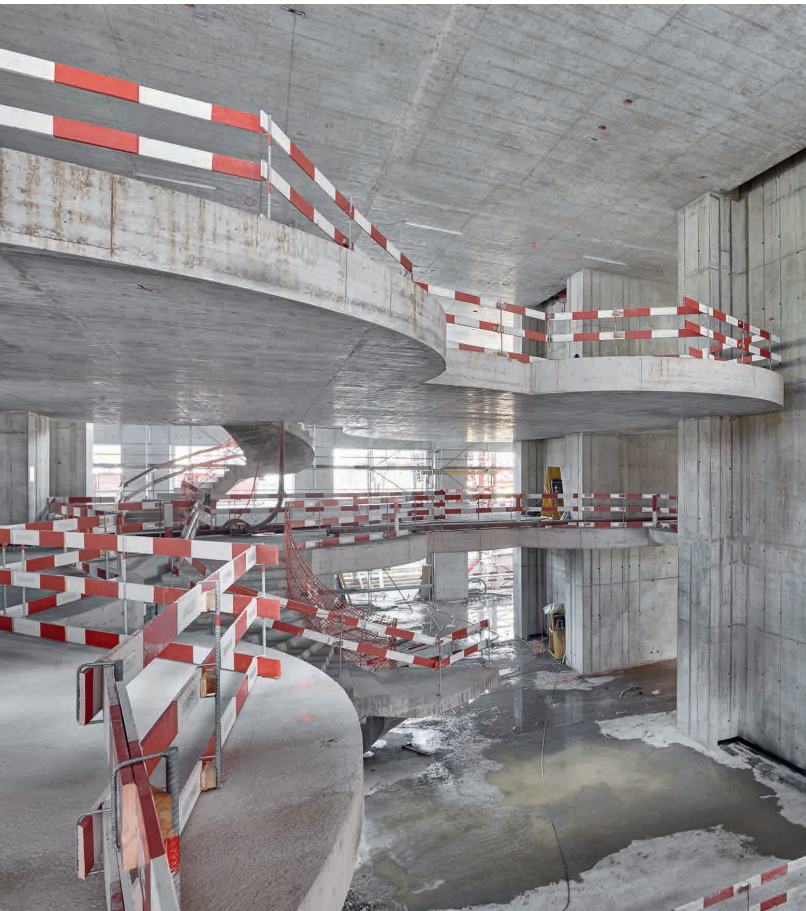
Halle mit seerosenartigen Plattformen in der Rohbauphase
