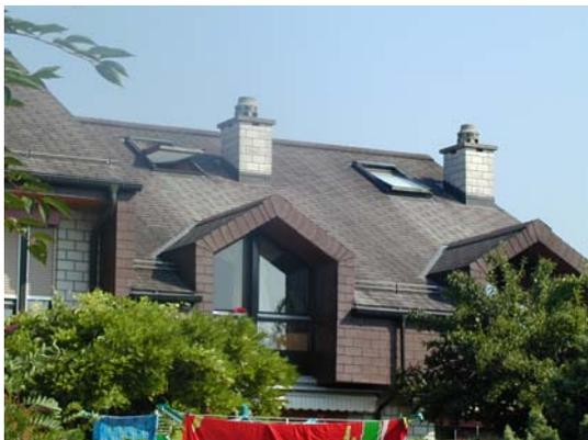
*Dachschiefer aus Asbestzement, Foto: JMF/SLE, IST*
