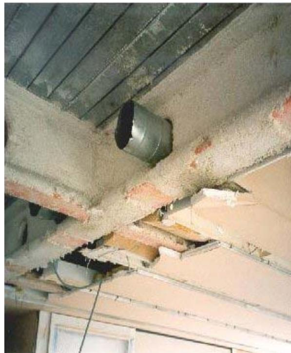
*Spritzasbest an einer metallischen Tragkonstruktion, Foto: JMF/SLE, IST*
