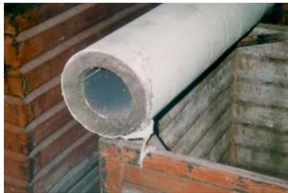
*Asbesthaltige Rohrisolation, Foto: MS, IST*
