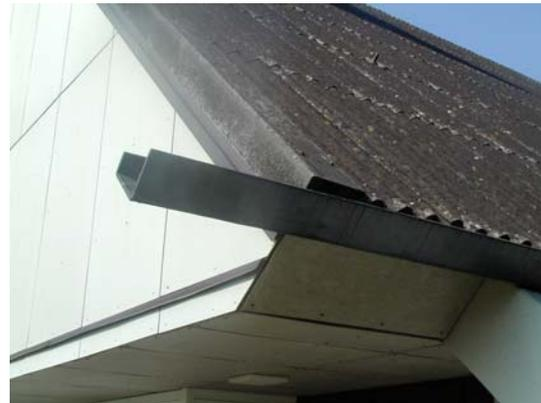
*Asbestzement-Wellplatten, Foto: JMF/SLE, IST*
