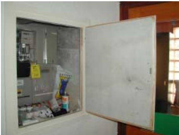
*Sicherungskasten mit asbesthaltiger Brandschutzplatte an der Innentür, Foto: JMF/SLE, IST*
