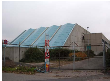
Zwischenpumpwerk der ARA Basel
