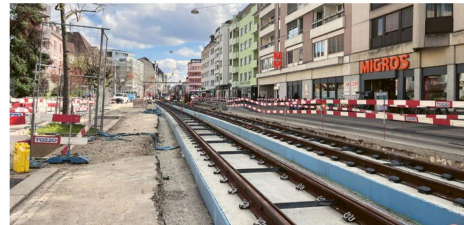
Neu einbetonierte Gleise in Richtung Burgfelderplatz
