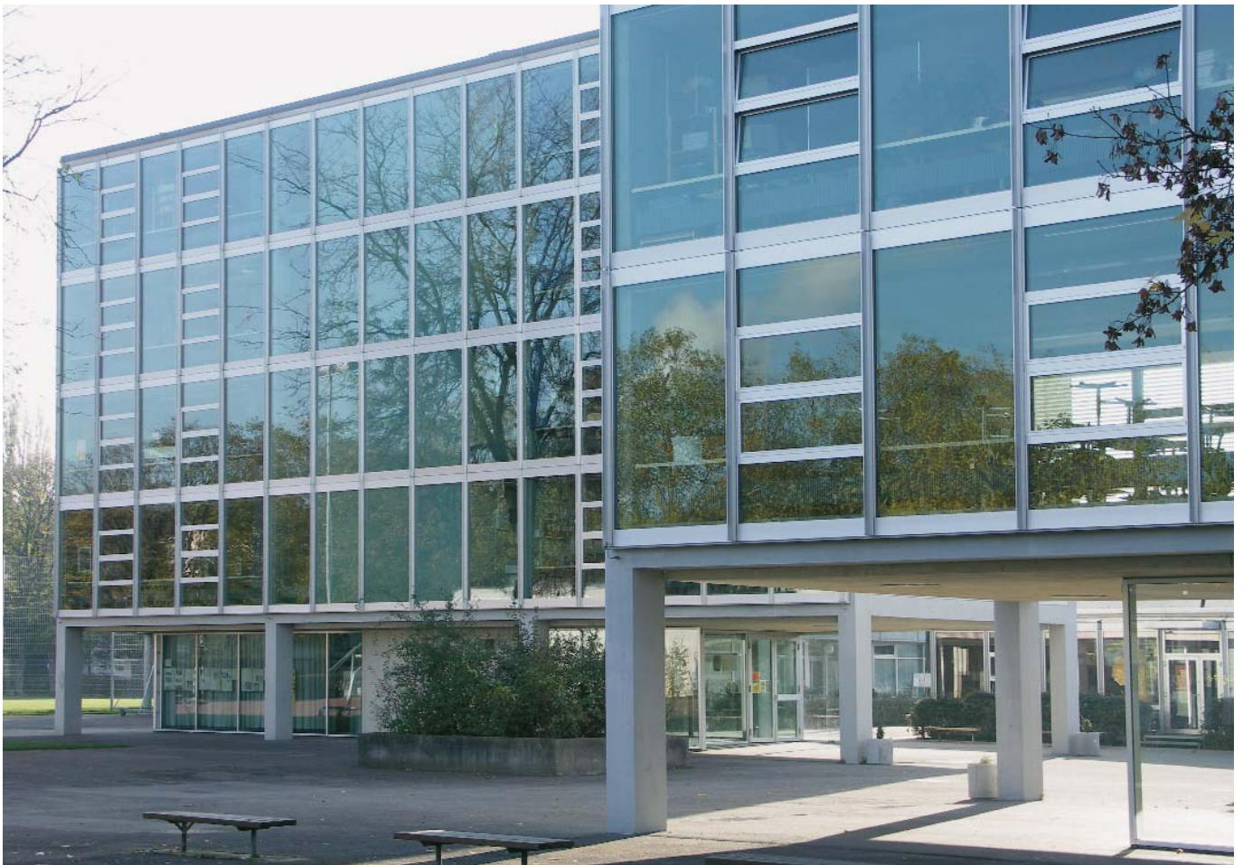
NORDFASSADEN GEBÄUDE 9 UND 10
