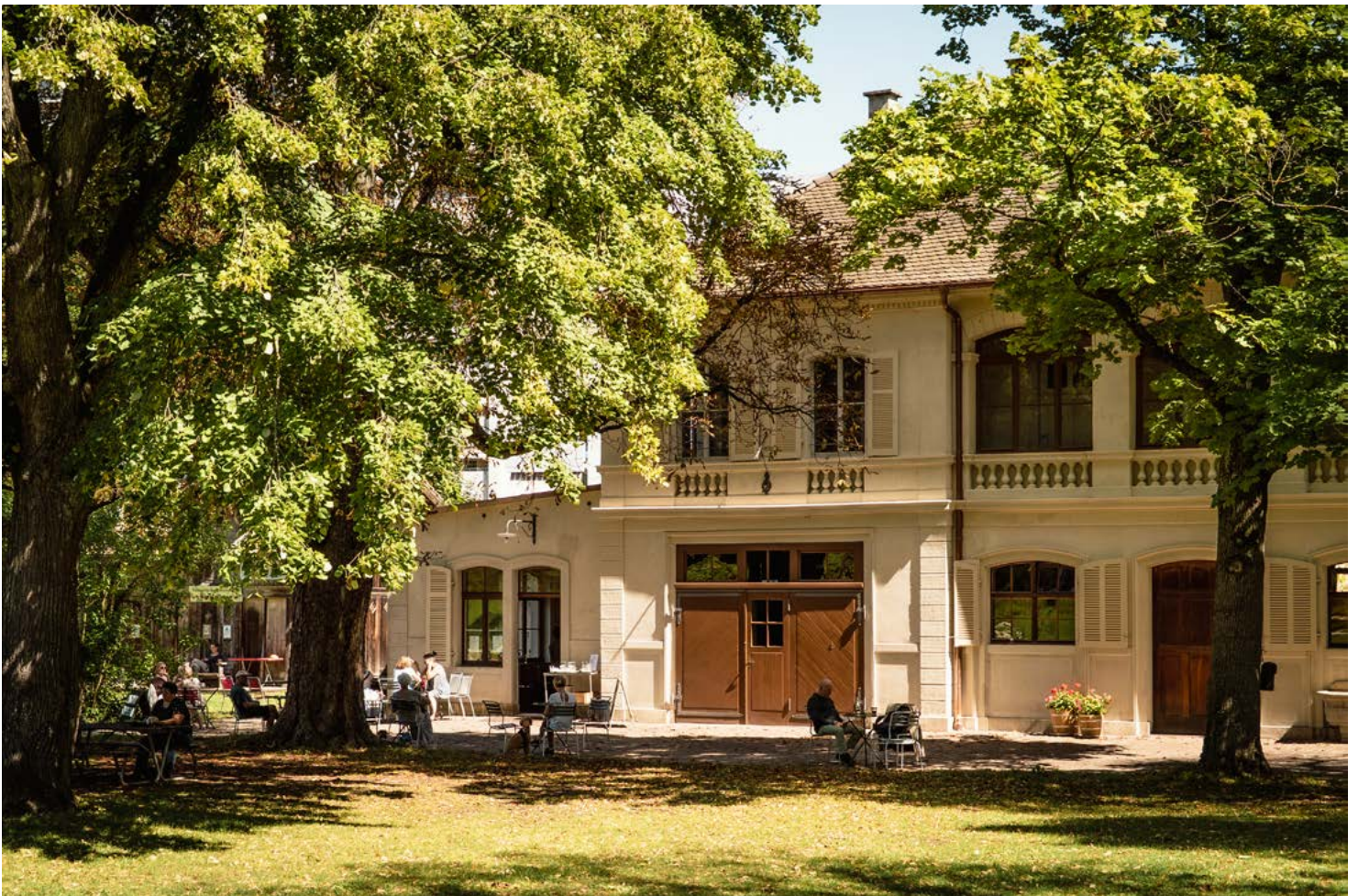
Aussenansicht saniertes Gärtnerhaus
