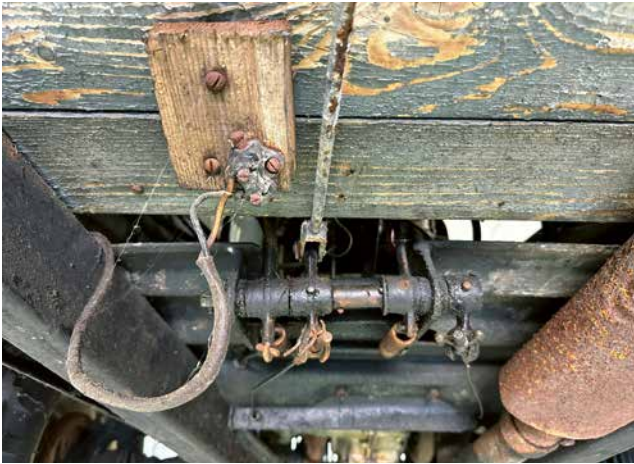
Blick auf den Unterboden mit der Holz-Stahl-Konstruktion.
