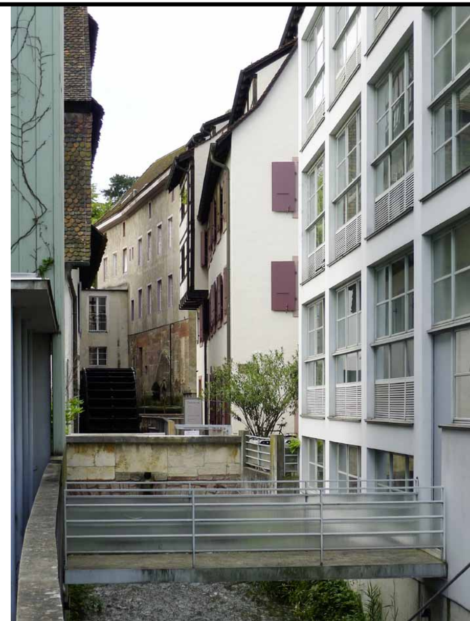
Diener & Diener, Wohnhäuser mit Ateliers, 1984–1986. Der westliche der beiden Bauten schliesst den mit Kastanien bepflanzten Platz am Rheinweg ab und steht mit seiner als Betonraster ausgebildeten Rückfassade direkt am hinteren Teich.
