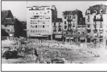
S. 24 Bauplatz der Basler Kantonalbank mit Sicht auf den Blumenrain, 1933 Fotograf unbekannt Staatsarchiv Basel-Stadt, AL 45, 6-67-5
