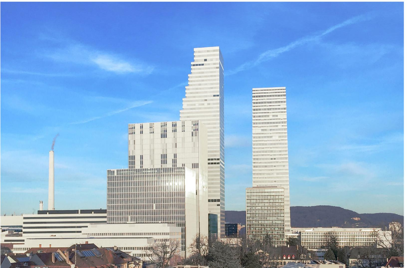
Der Fensteranteil an der Fassade der Roche-Türme ist verhältnismässig klein – zum Vorteil für den sommerlichen Wärmeschutz.
