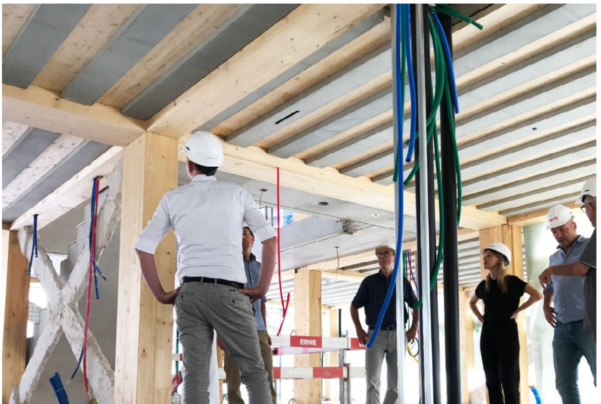
Begutachtung der Holz-Beton-Verbund-Decke, Foto: jessenvollenweider
