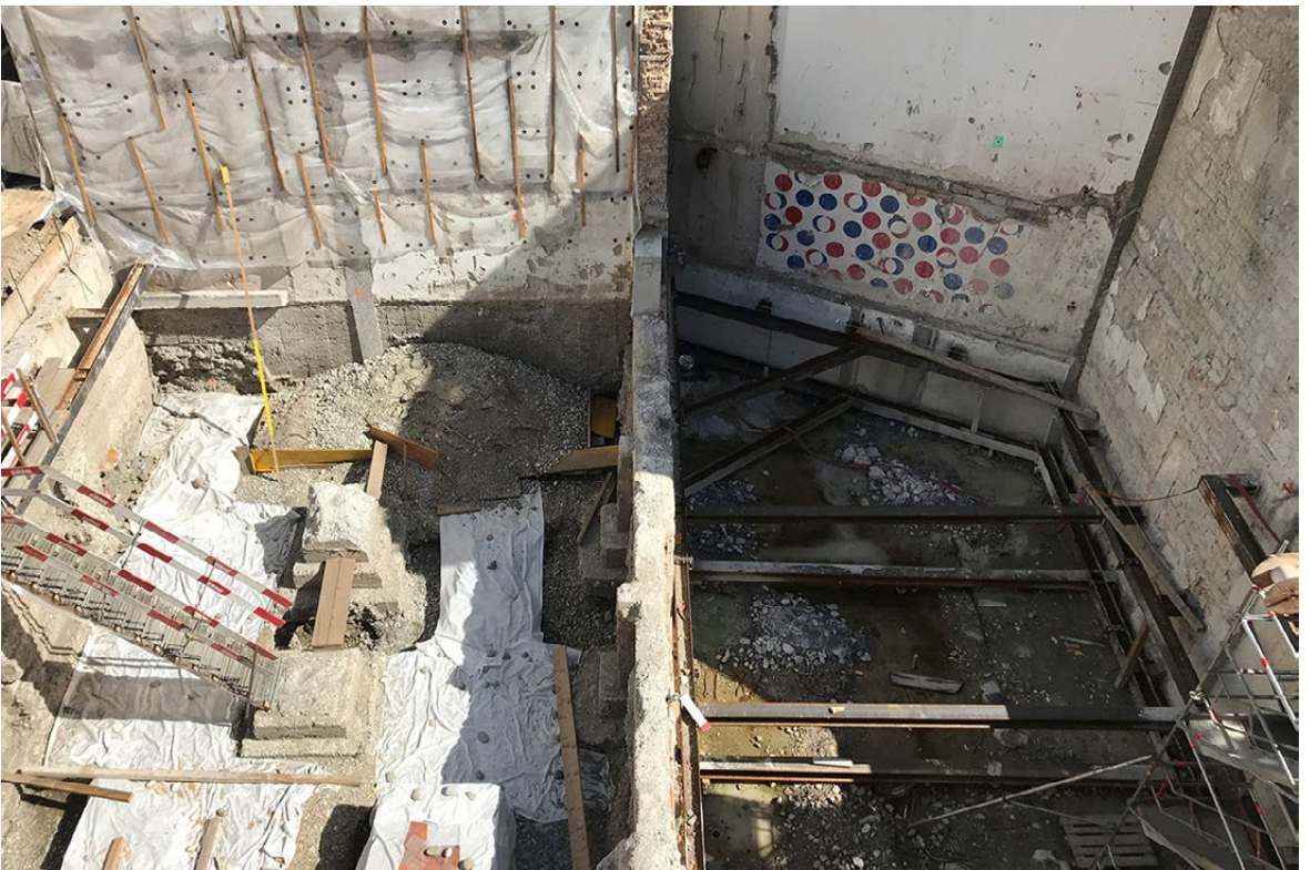
Blick in die Baugrube Foto: jessenvollenweider
