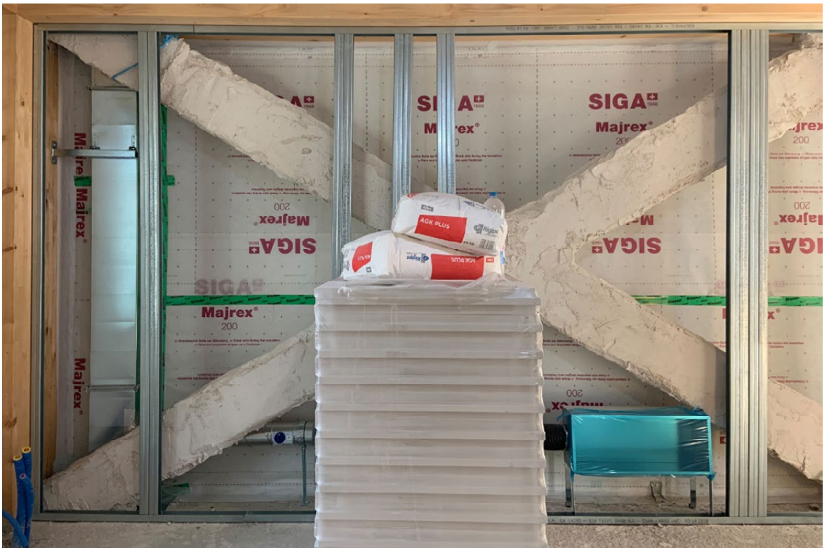
Gipswand vor dem Bepanken, Foto: jessenvollenweider
