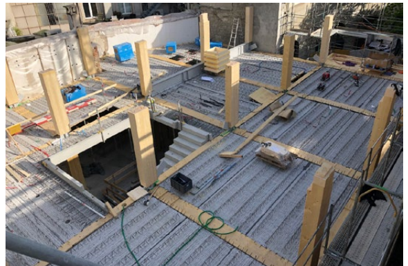
Eingebaute Deckenelemente aus Holz-beton-Verbund, vgl. nächste Seite
