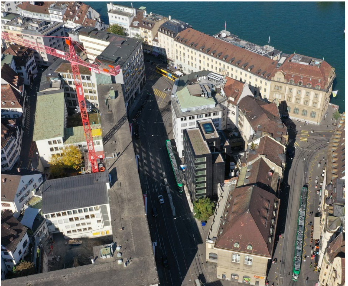
Der fertiggestellte Neubau Amt für Umwelt und Energie aus der Vogelperspektive. Foto: jessenvolenweider
