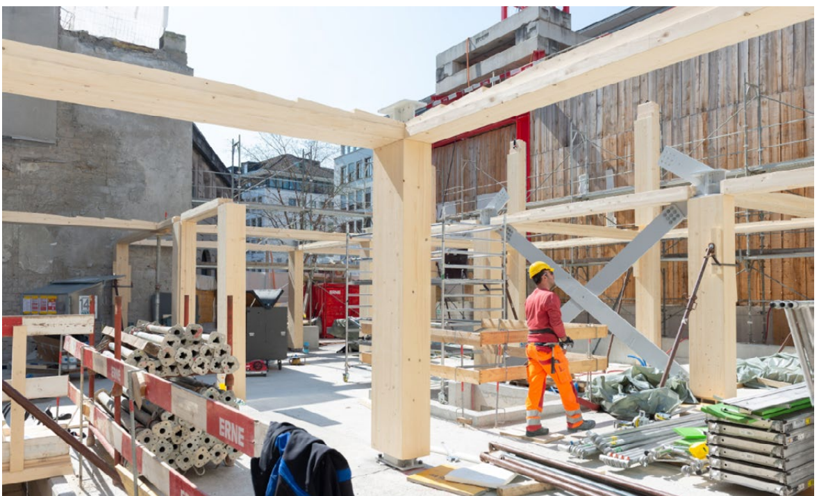
Verbindung von Stahl- und Holzelementen, Fotos: b+p baurealisation ag
