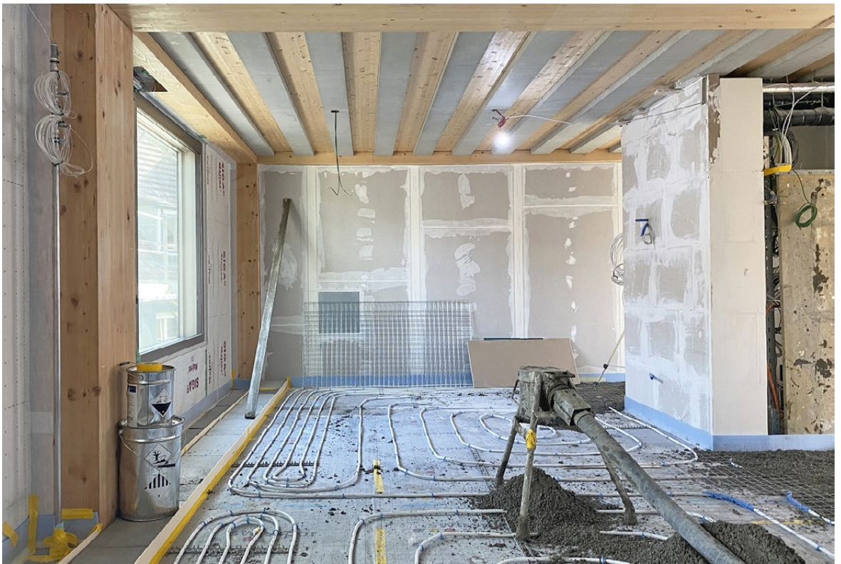
Einbringen des Hartbetons im Bürogeschoss, Foto: jessenvollenweider
