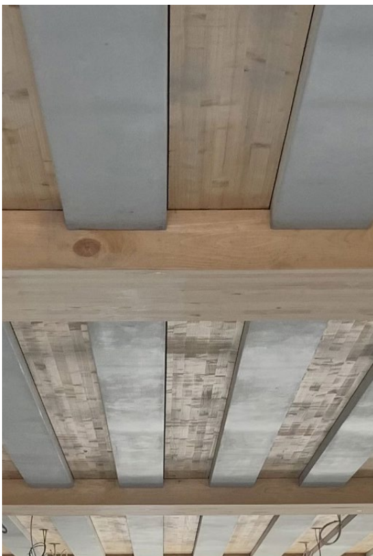
Links Holz-Beton-Verbunddecke ohne Akustikelemente, rechts mit. Foto: jessenvollenweider
