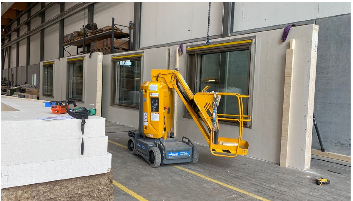
Fertiges Fassadenelemente in der Produktionsstätte
