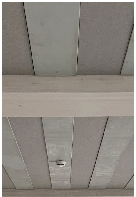
Links Holz-Beton-Verbunddecke ohne Akustikelemente, rechts mit. Foto: jessenvollenweider
