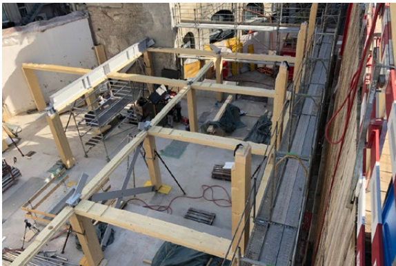
Aufbau des Holzskeletts
