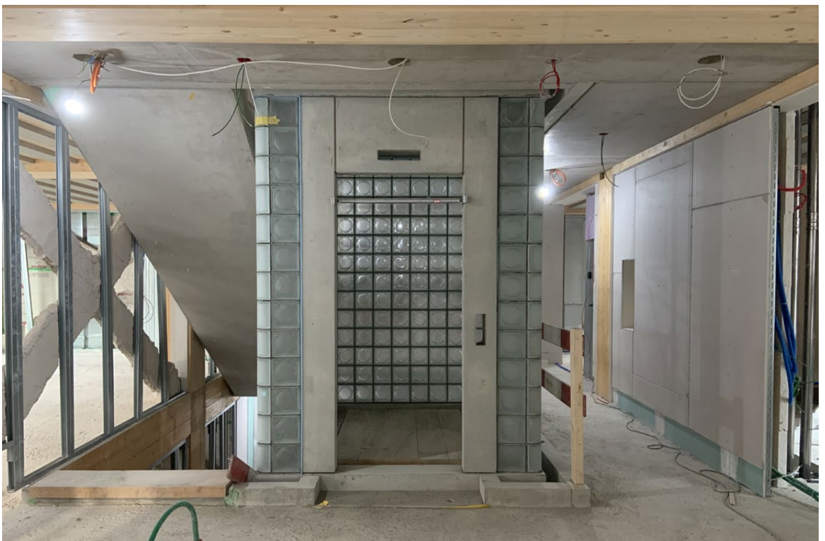
Treppenhaus mit Liftschacht aus Glasbausteinen, Foto: jessenvollenweider
