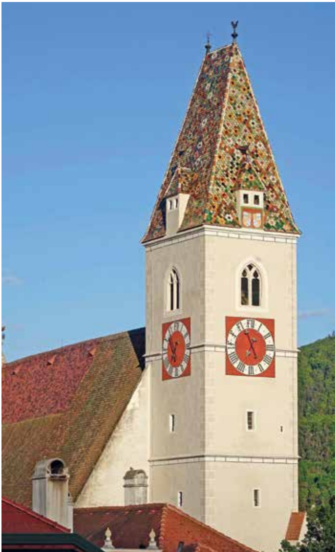
Pfarrkirche St. Mauritius in Spitz an der Donau (NÖ). Von den farbig glasierten Flachziegeln stammen noch 80 % aus der Zeit der Ersteindeckung um 1500.
