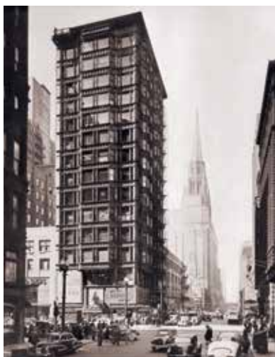
Die Fassade des Reliance Building in Chicago (1894/95, Charles B. Atwood bei D.H. Burnham & Company) ist das wohl berühmteste Beispiel für eine Frühform der späteren Curtain Wall.
