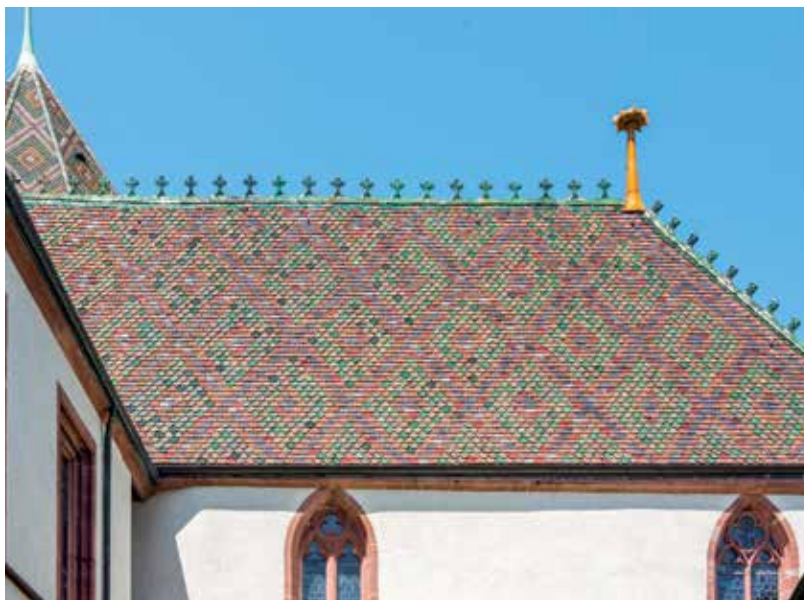
Das Dach der Niklauskapelle am Basler Münster mit farbig glasierten Dachziegeln aus dem Spätmittelalter.
