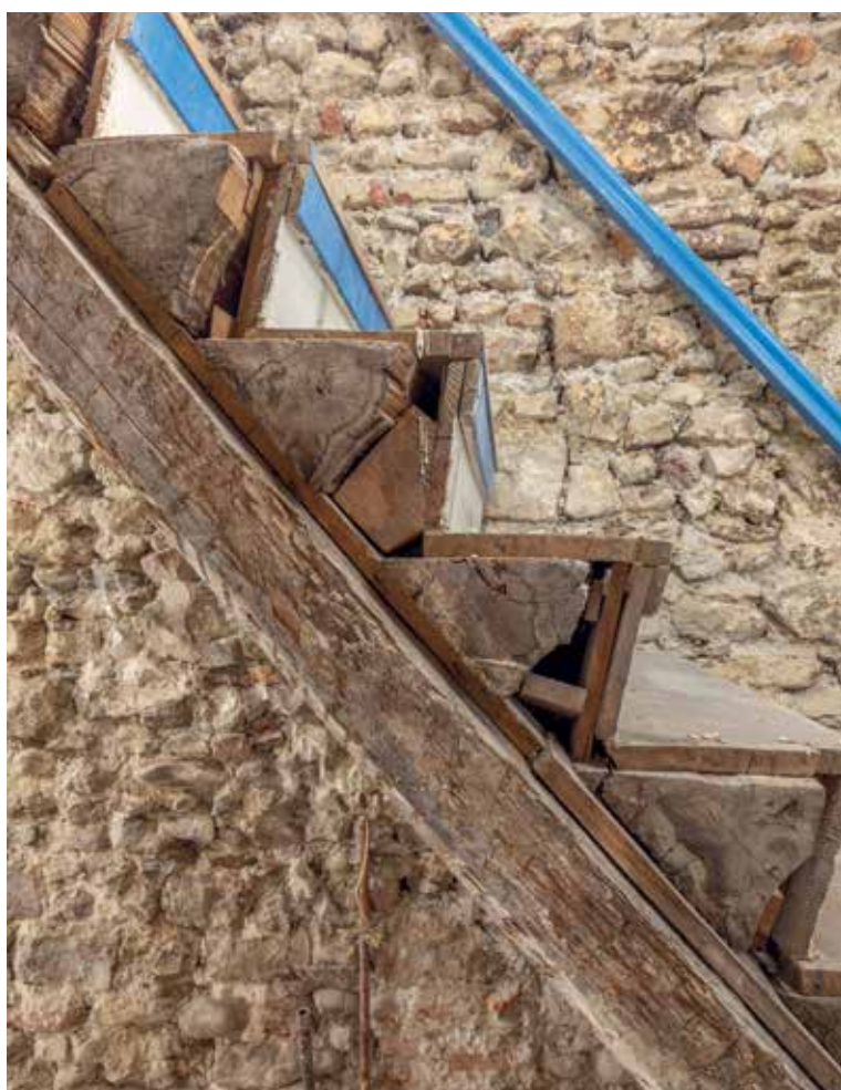
Blockstufentreppe an der bergseitigen Brandmauer, Zustand nach der Freilegung. Die Blockstufen wurden bei ihrer einstigen «Modernisierung» neu verlegt, vorne zurückgeschnitten und mit Brettern eingeschalt.
