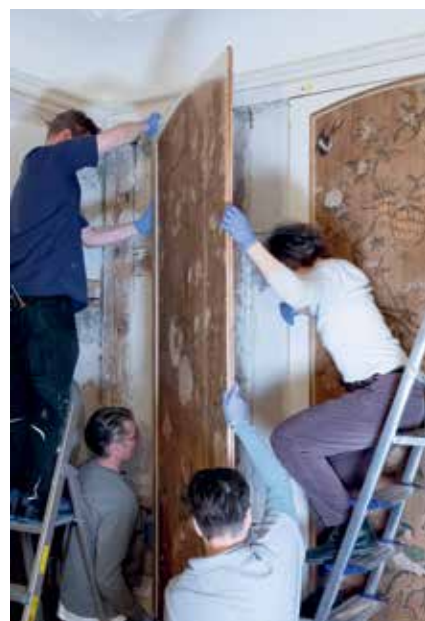
Ausbau eines Panels für Zustandsuntersuchungen und Materialanalysen durch Mitarbeitende des Sammlungszentrums des Schweizerischen Nationalmuseums am 30. Januar 2024.
