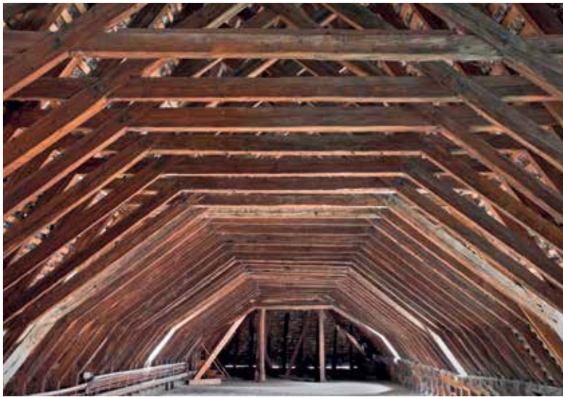
Ein herausragendes Beispiel mittelalterlicher Zimmermannskunst und zudem eines der ältesten seiner Art in Basel: das Dachwerk über dem kasernenseitigen Trakt des Kleinen Klingentals, dendrochronologisch datiert ins Jahr 1274.
