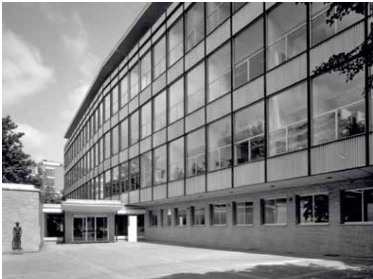
Ciba-Bau 430. Die Entwurfszeichnung und das kurz nach Baufertigstellung aufge- nommene Foto der Westfassade mit dem vorgelagerten Eingangsbereich zeigen die klare Struktur der umlaufenden Vorhangsfassade und die besondere Spannung, die durch den leichten Knick in der Fassade erzeugt wird.
