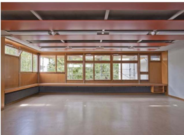
Klassenzimmer mit abgehängten Akustikpaneelen zur Minderung der Nachhallzeiten. In die bestehenden Fenster wurden neue Wärmeschutzverglasungen eingebaut.
