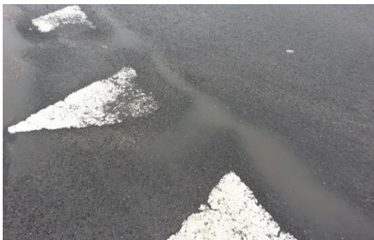
Übermässiger Abrieb in 3-jährigem Testbelag
