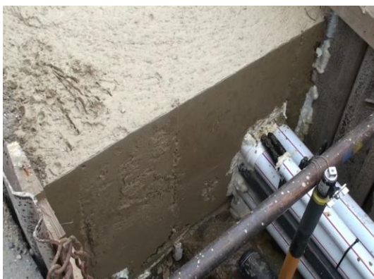
Flüssigboden nach Ausbau des Schotts
