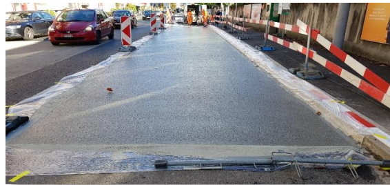
Frisch eingebauter VB11 (hier das Produkt CONFALT)
