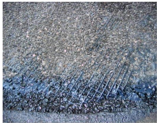
Stressabsorbierende Mastix Inlay (SAMI) spannungsabsorbierende Membrane
