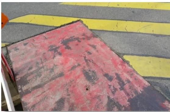
Versenkte Stahlplatte in Fahrbahn
