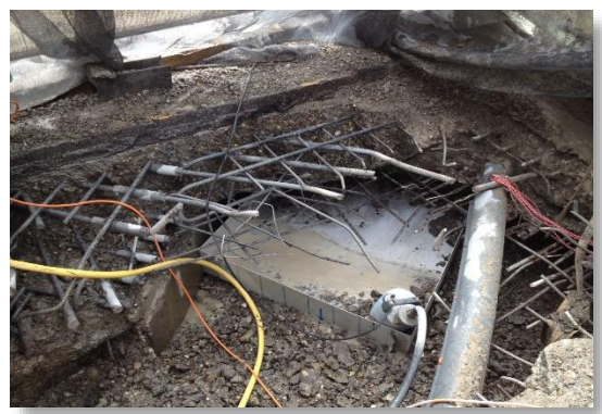
Durchtrennen statischer Brückenbewehrung
