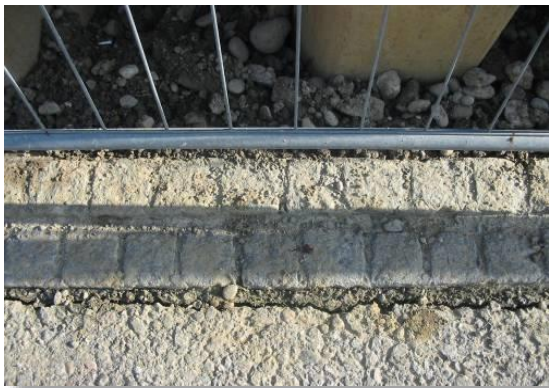
Abgehängter Randabschluss (Baugrube)
