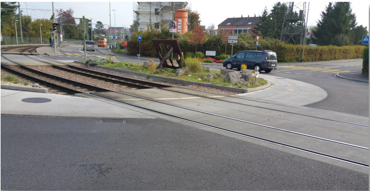
Mögliche Kreisgestaltung mit Tramdurchführung (Randmarkierung fehlt hier)
