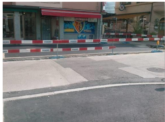
Tragschicht: Flick an Flick im Kreuzungsbereich
