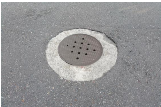
Beton statt Belag (Blick auf Binderschicht)
