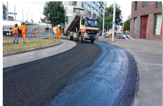
SAMI mit vorumhülltem Splitt wird eingebracht
