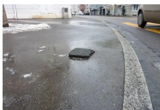
Frosthebung (keine Frostsicherheit)
