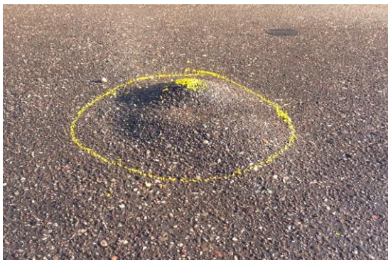
Dampfblase unter Gussasphalt ("Warze")
