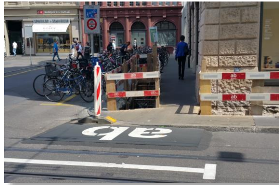
Versenkte Holzdielen mit angeramppter Stahlplatte
