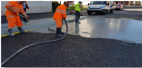
Verfüllen des bituminösen Belags mit der Schlämme
