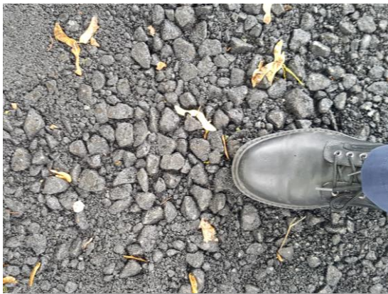
Entmischte "definitiv" eingebaute Tragschicht
