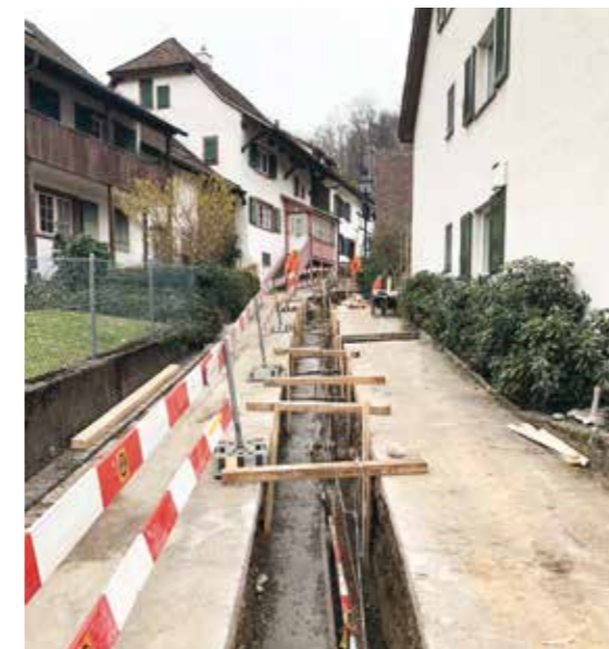
Werkleitungsarbeiten im Jägerweg, Foto: Andres Linder
