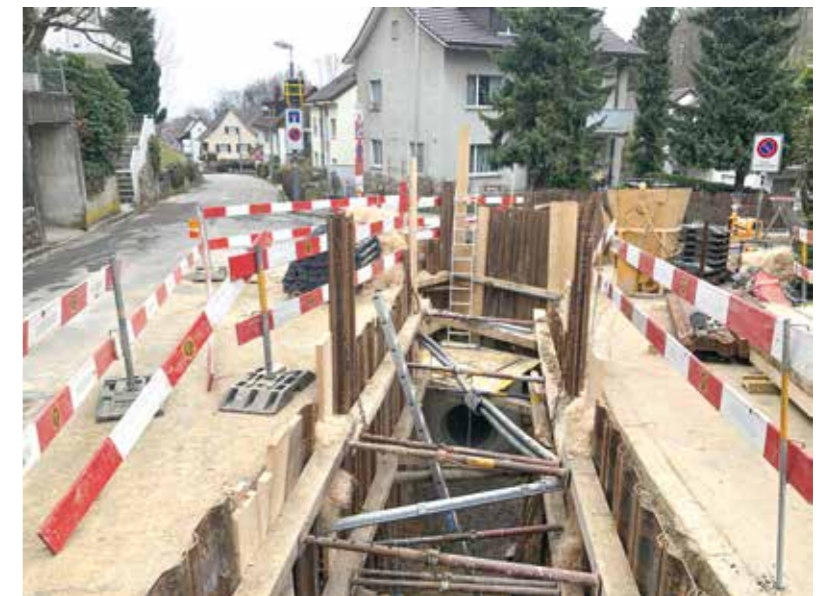
Grabarbeiten für die neue Regenwasserleitung im Bereich Baiergasse, Mennweg, Foto: Andres Linder
