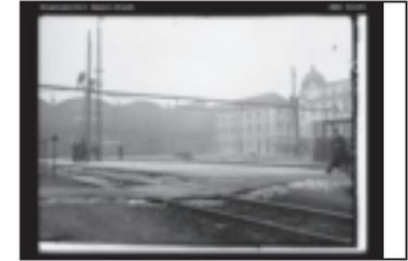
**S. 9/10** Bahnhof SBB, Elektrifizierung der Bahn, Errichtung der Masten für die Montage der Oberleitungen
