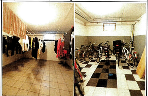
Trockenraum und Veloabstellraum allgemein im SG
