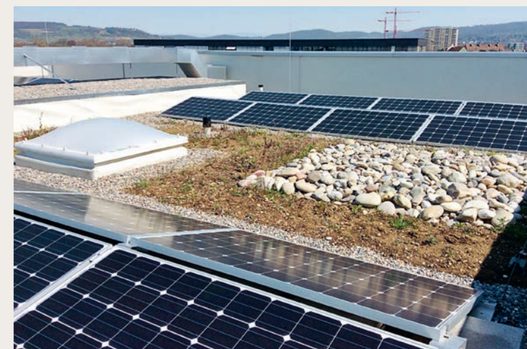
Trennung Dachbegrünung und Solaranlage im Verhältnis 40/60 Foto: Stadtgärtnerei Basel
