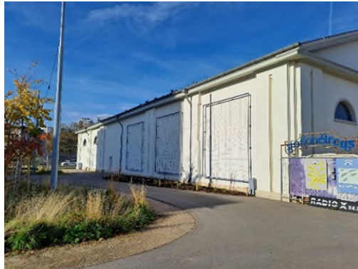
Bilder: Testflächen zur Fassadenbegrünung am Tramdepot Dreispitz (Quelle: Kanton Basel-Stadt)
