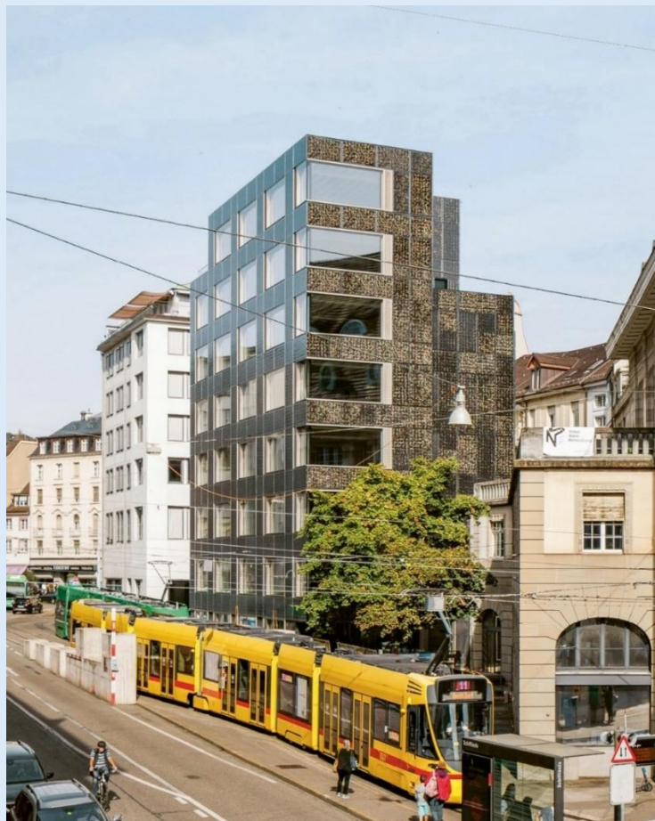
Ein besonderes Merkmal des Gebäudes ist die allseitige Photovoltaikanlage. ©hochparterre.ch
