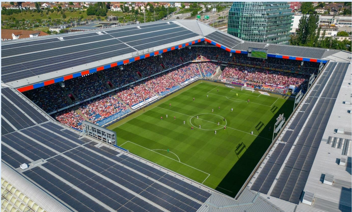
Auf dem Dach des Joggeli ist eine Photovoltaikanlage. ©FC Basel 1893
