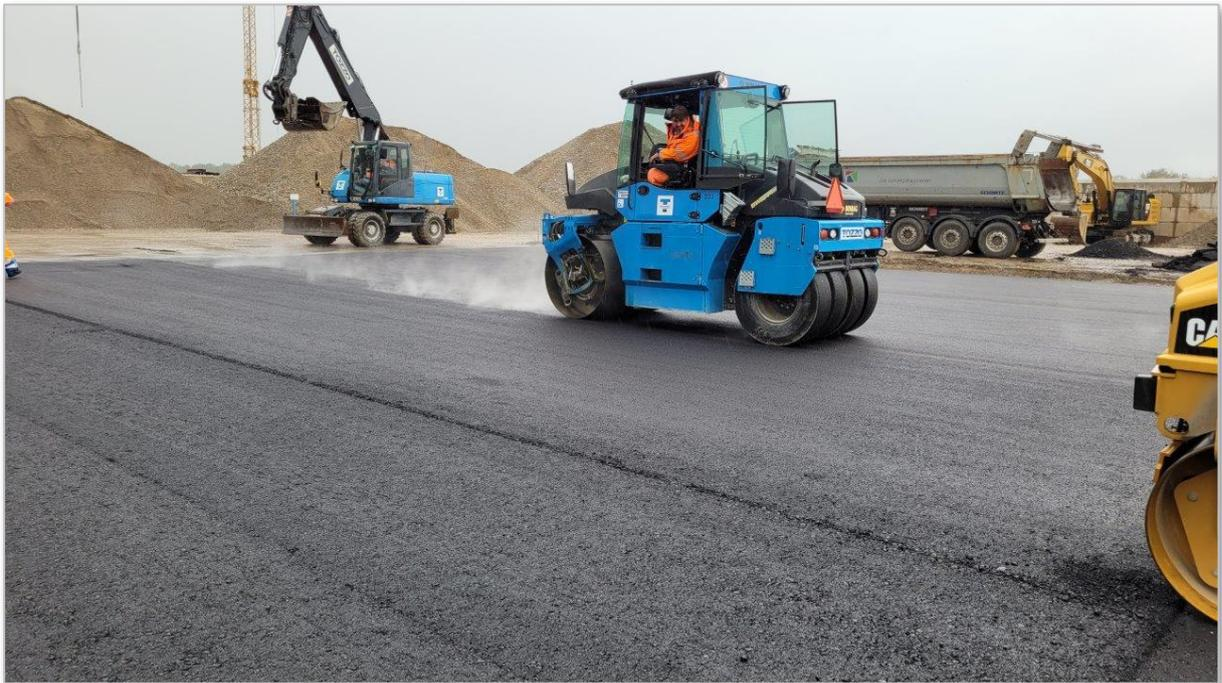
*Abbildung 2 Belagseinbau Pflanzenkohle - Asphalt Versuchsfläche habö AG im September 2022.*
