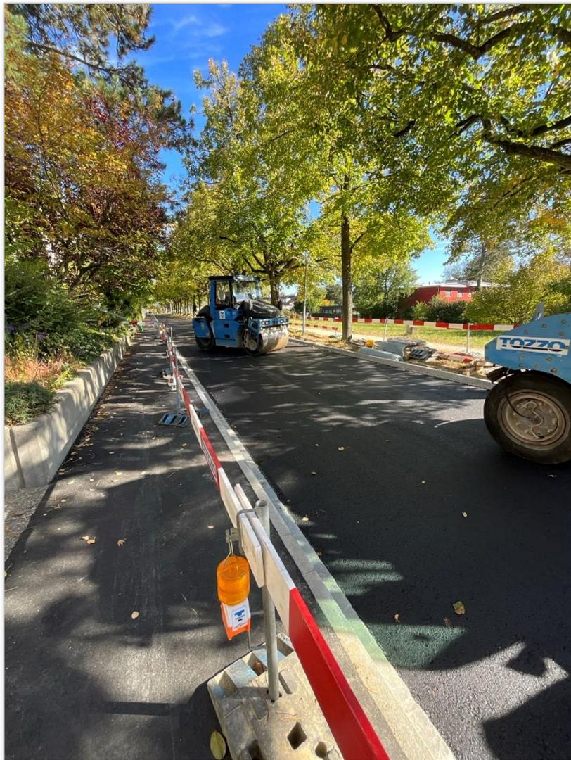
Abbildung 6 Belageinbau Pflanzenkohle -Asphalt in der Reservoirstrasse, Kanton Basel - Stadt im Oktober 2023.
