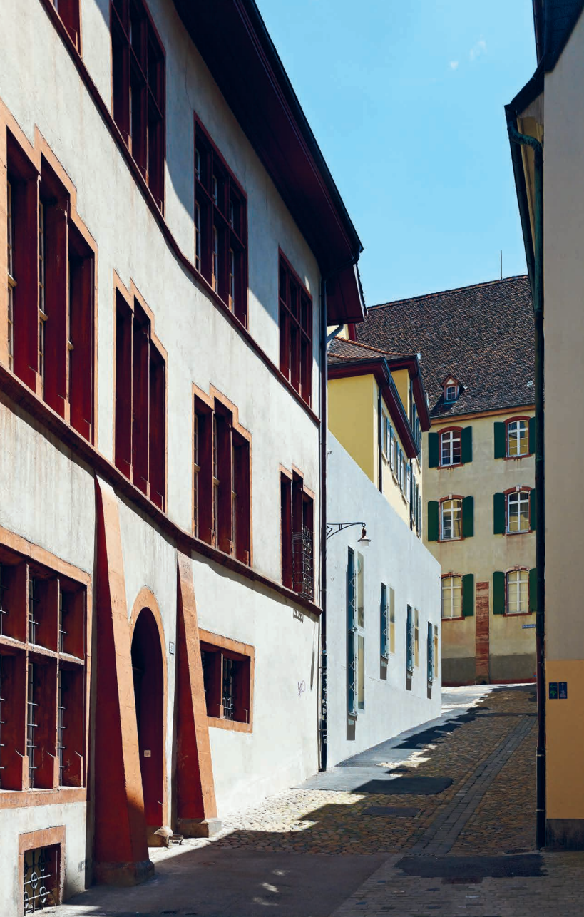
Aussenfassade mit geöffneten Fenstern
