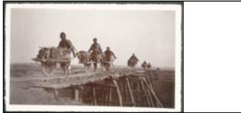
S. 32 Arbeiter beim Bau
