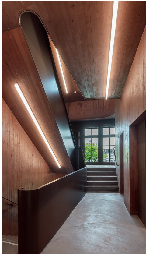
Treppenhaus in eingefärbtem Beton
