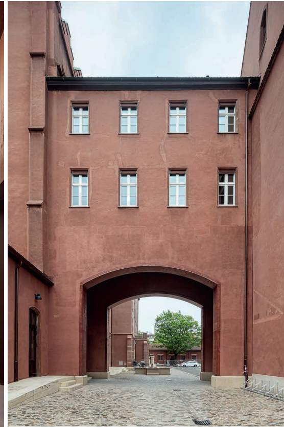
Neuer, seitlicher Durchgang – Verbindung zum Rhein
