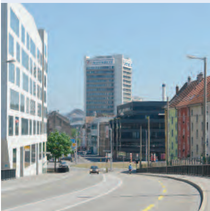
Luzernerring-Brücke, Blick Richtung Lothringerplatz
