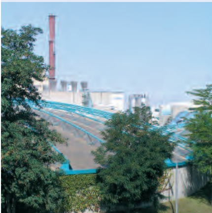
Abwasserreinigungsanlage in Kleinhüningen
