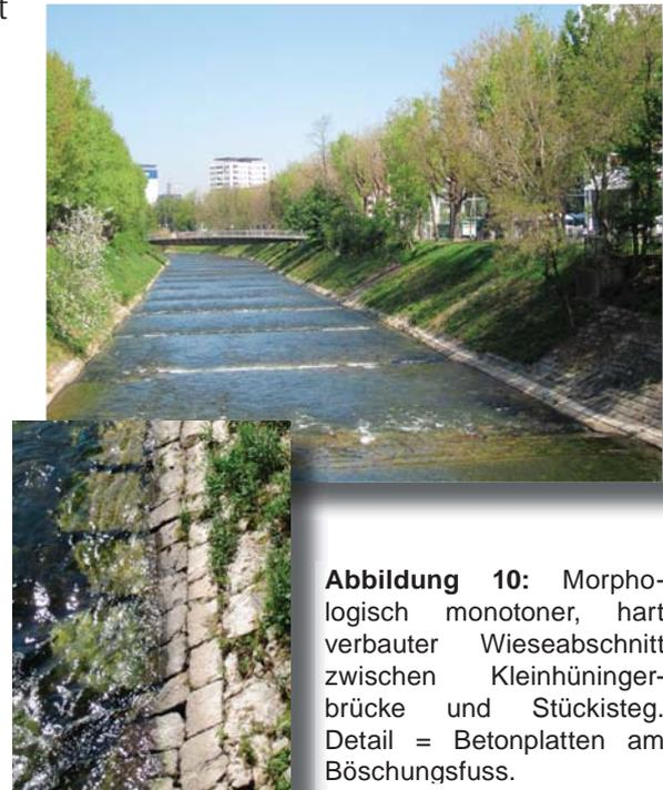
**Abbildung 10:** Morphologisch monotoner, hart verbauter Wieseabschnitt zwischen Kleinhüningerbrücke und Stückisteg. Detail = Betonplatten am Böschungsfuss.
