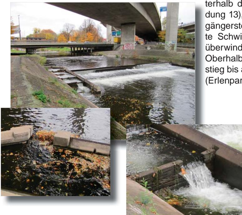
**Abbildung 12:** Beckenpass bei der Schwelle des Kleinhüninger Mühlewehrs. Details: Mit Geschwemmsel verstopfter Ausstieg (links), Überfall im Kronenausschnitt zwischen zwei Becken.
