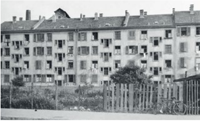
Typische Arbeiterwohnhäuser an der Maulbeerstrasse. Foto von 1938.
