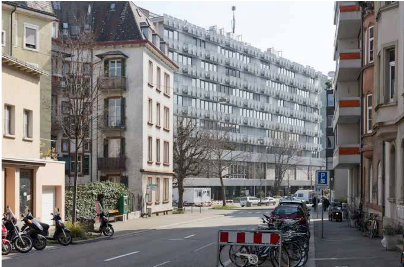
BILD UNTEN Blick von Nordwesten (Aufnahmen 2015)
