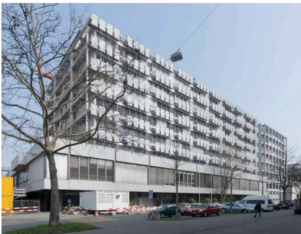
Ansicht von Nordwesten / Klingelbergstrasse
