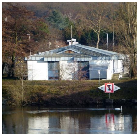
Rheinüberwachungsstation Weil (Rüs)
