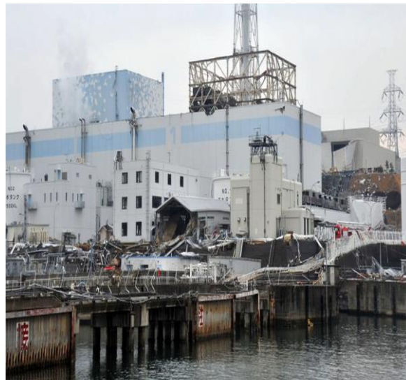
Kernkraftwerksgelände von Fukushima Dai-jchi
