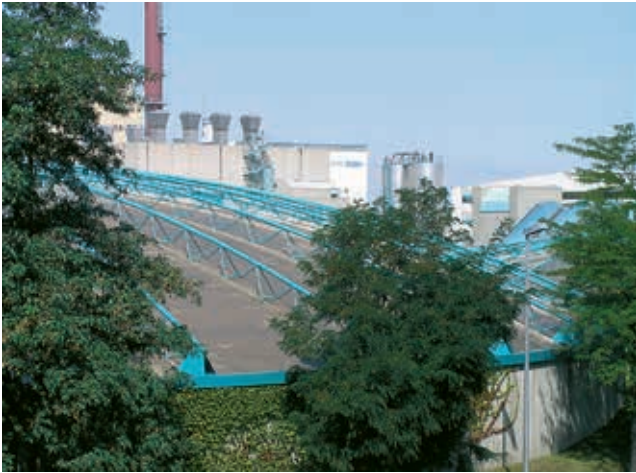
Abwasserreinigungsanlage in Kleinhüningen
