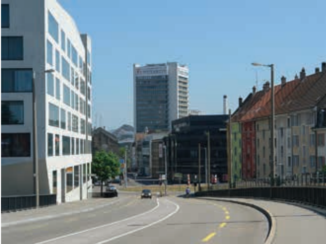
Luzernerring-Brücke, Blick Richtung Lothringerplatz
