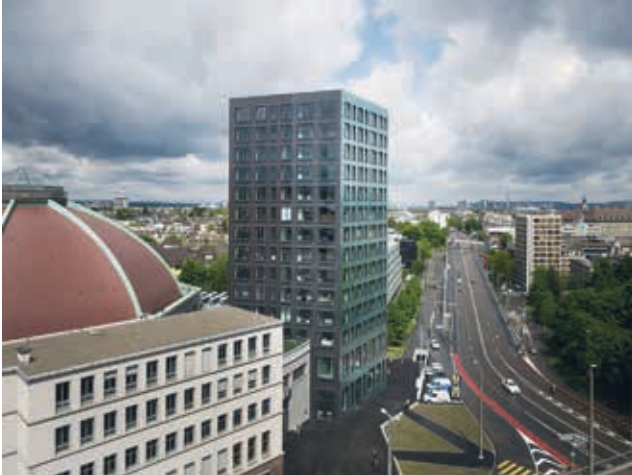
Markthalle, Wohnhochhaus am Steinentorberg
