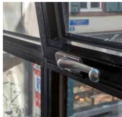
**Domus-Haus-Details:** In die Gipsdecke integrierte Leuchte aus der Bauzeit mit Metallzylinder und Opakglasabdeckung (Die Befestigungsschraube ist jüngerer Datums). – Fensterflügel mit bauzeitlichem Schliessmechanismus und Griff. – Originaler Umlegehebel für den Kippmechanismus der Fensterflügel.
