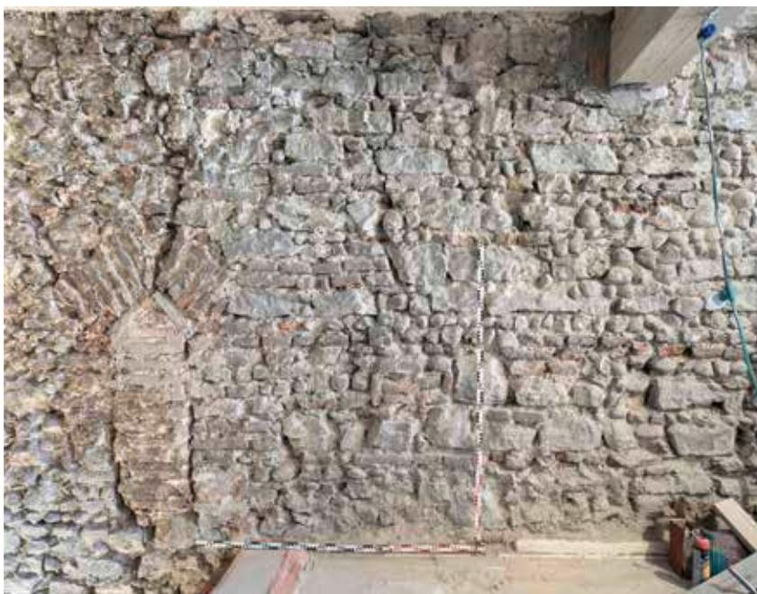
**4** – Südliche Brandmauer im 3. Obergeschoss des Vorderhauses: Wiederaufbau des Nachbarhauses zum Wildenstein (Spalenberg 18) von 1361 mit ehemaligem Fenster.
