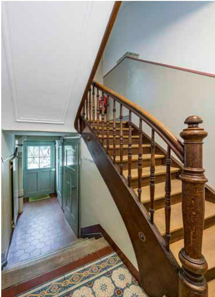
Besonderes Augenmerk verdient das hochwertige und gut erhaltene Treppenhaus mit seiner Treppenanlage inklusive Staketengeländer, der originalen Rufenbespannung und Abschlussleiste sowie den bauzeitlichen Bodenbelägen mit geometrisch-floral verzierten Keramikfliesen. Links: Eine der bauzeitlichen Wohnungsabschlusstüren.
