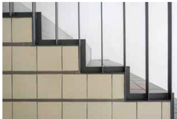
Differenzierte Oberflächengestaltung im Innern: Bodenbelag im 3. Obergeschoss mit Fliesen in unterschiedlicher Grösse, Farbigkeit und Setzung; geflieste Wandpartie im Treppenhaus.
