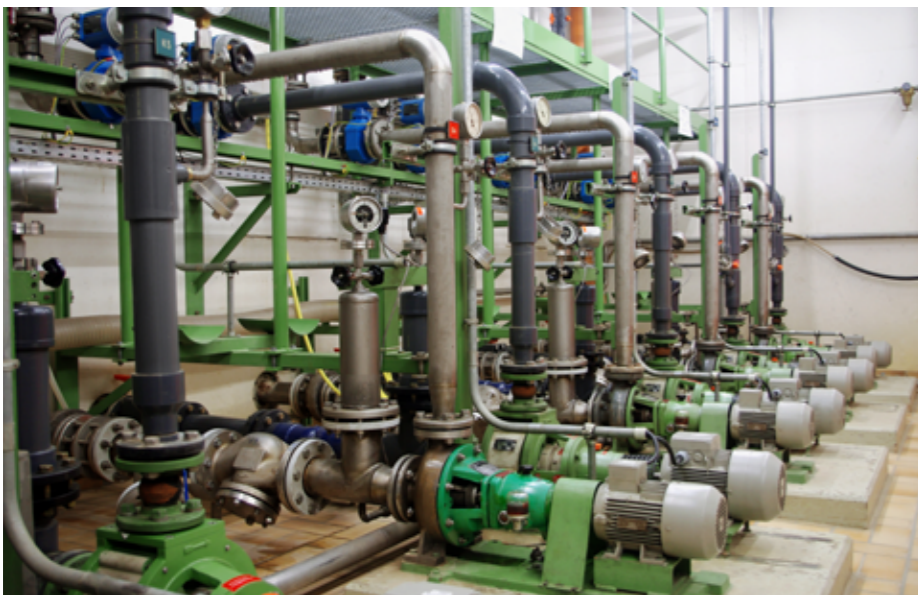
Entnahmestrange in der Rheinüberwachungsstation. Bild: Alexandra von Ascheraden
