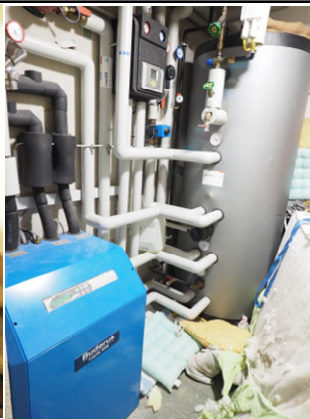
Vorplatz/Treppe u. Heizraum mit Wärmepumpe-Zentralheizung u. Boiler im KG
