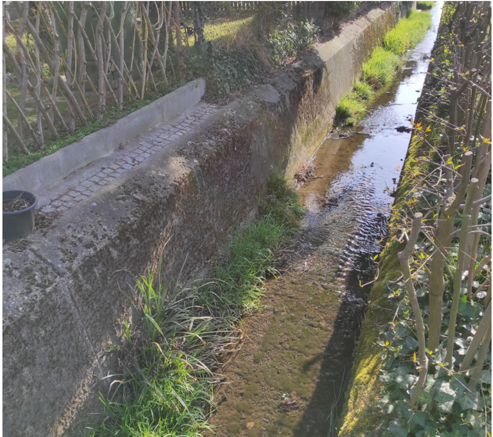
Abbildung 6: DO1: Der stark verbaute Abschnitt des Dorenbaches DO1 liegt verbaut zwischen Siedlung und Strasse. Im Bachbett liegen vereinzelt Abfälle sowie heterotropher- und Algenbewuchs sind deutlich sichtbar.
