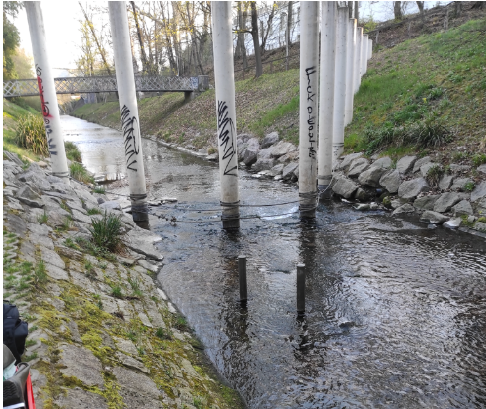
Abbildung 5: Birsig unterhalb des Dorenbachviadukts (BG2). Die Säulen im Querprofil sollen Verkläunungen im weiter unten liegenden Bereich der Eindolung verhindern.
