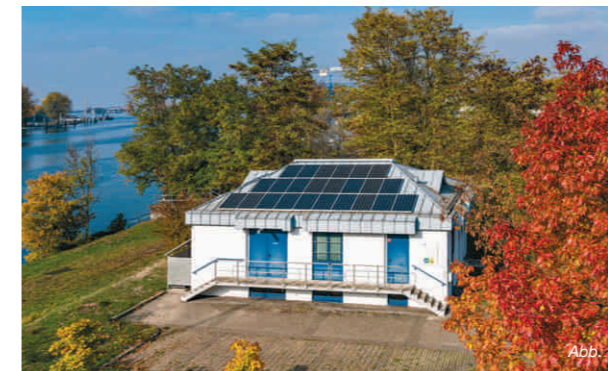
Gebäude der Rheinüberwachungsstation direkt am Rhein
