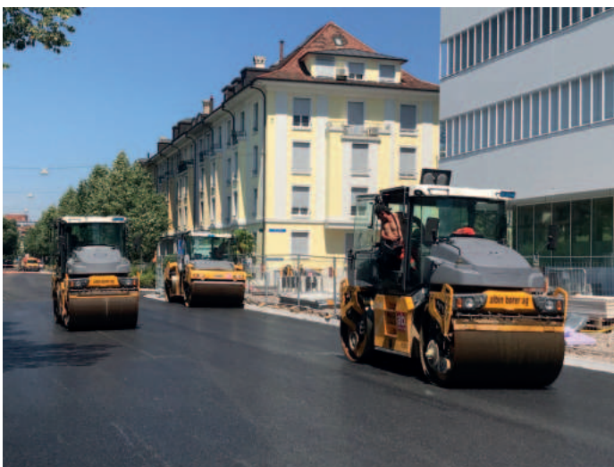
Strassenbau in der Peter Rot-Strasse
