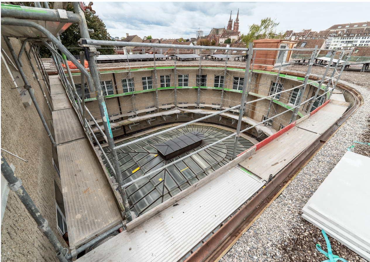
Sanierungsarbeiten im Amt für Wirtschaft und Arbeit, Utengasse 36
