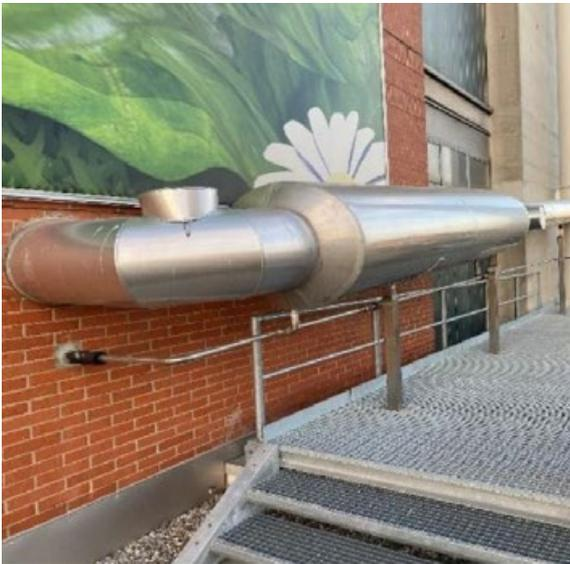
*Das am Gebäude entlanggeführte Lüftungsrohr ist mit einem Schalldämpfer ausgerüstet.*
