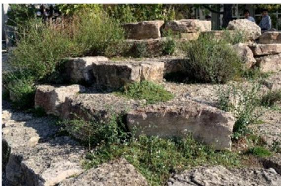
*Die Kombination aus Stufen und offenporigem Boden erhöht die schallabsorbierende Eigenschaft dieser Böschung.*
