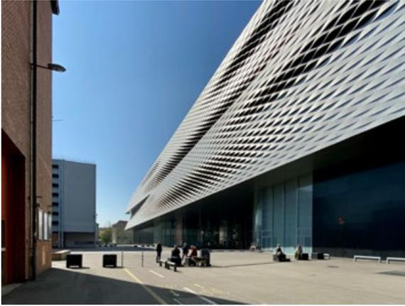
*Im Gegensatz zu einer glatten Beton- oder Glaswand absorbiert diese stark strukturierte Alufassade den Umgebungslärm besser.*
