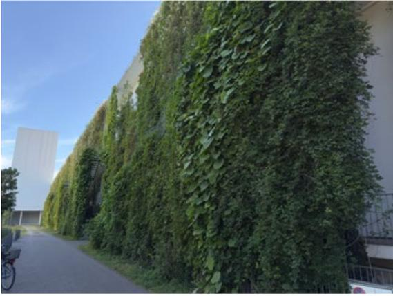
*Gleichzeitig mit der optischen Aufwertung wird insbesondere durch die diffuse Reflexion der Umgebungsgeräusche an den Blättern eine akustische Verbesserung erzielt.*
