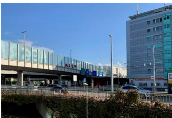
*Die verglaste Lärmschutzwand an der Autobahnbrücke gibt den unteren Stockwerken der umliegenden Mehrfamilienwohnhäuser Schutz vor übermässigem Verkehrslärm und schirmt auch den angrenzenden Aussenraum vom Lärm ab.*
