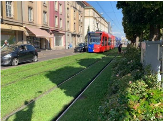
*Der Verkehrslärm von Trams ist deutlich gedämpft, wenn die Schienen nicht über asphaltierten, sondern über absorbierenden Untergrund wie zum Beispiel Rasenflächen verlaufen.*
