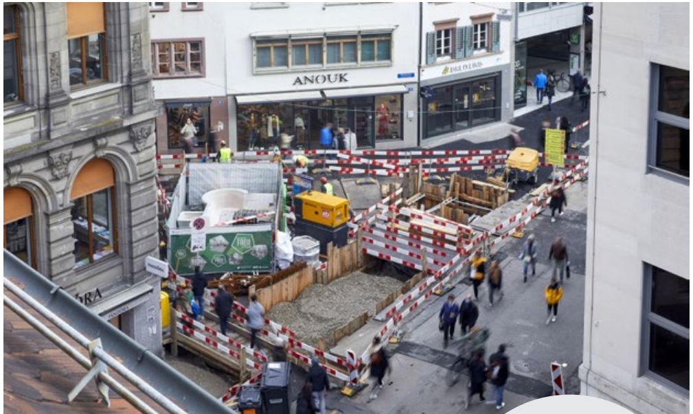
Fernwärme-Baustelle von IWB an der Freie Strasse
